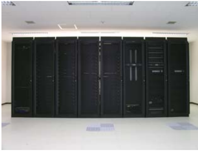
総合研究棟B棟
