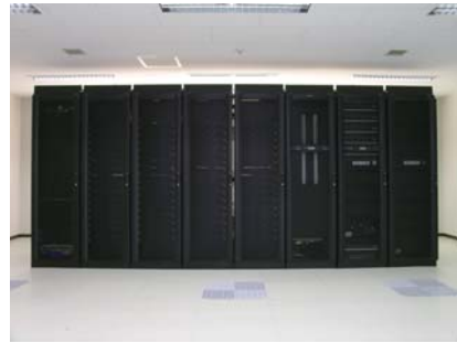
総合研究棟B棟
